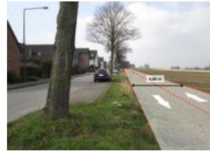
Vetschauer Weg (Höhe Am Gut Bau)
